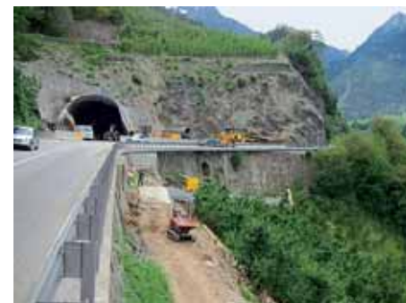
Tunnel 1 der Baustelle auf der Straße Forst-Töll.
